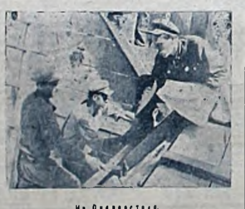
Плотники бригады Голыца за опалубкой шпатель стези. Первый створ — Носиф Голыца.
