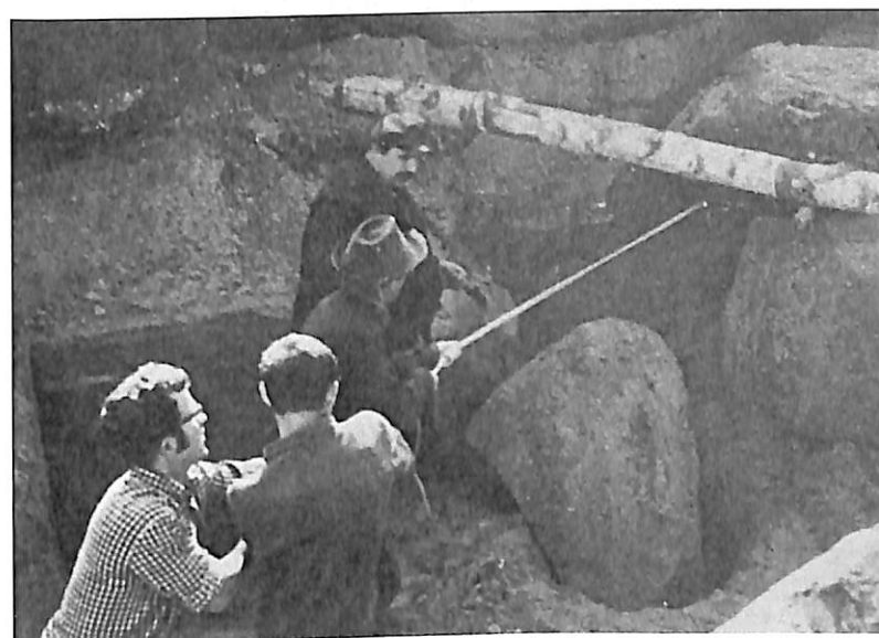
1971 год. Расчистка прохода
